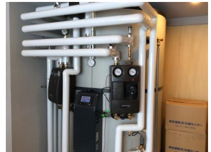
貯湯タンク設置の様子
