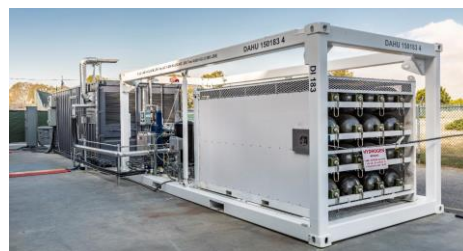
水素製造設備
