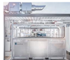
双方向発電機(150kW)
